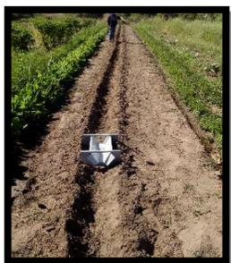
1. Limpiar la solera del canal y regularizar las paredes del mismo aguas arriba del aforador (al menos 2 m de distancia), en caso de ser necesario (Figura 8).
