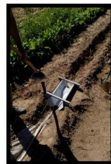
4. Impermeabilizar cuidadosamente los laterales entre el aforador y las paredes del canal para evitar filtraciones; para este fin se emplea la misma tierra y hierbas del lugar, algunas veces será necesario usar plástico (Figura 11).
